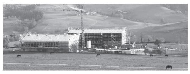
Spektakulär war im September der Aufbau der neuen Mehrzweckhalle aus vorgefertigten Holzelementen. Nachdem auf dem Fundament die Setzschwellen montiert waren, wurden – bei allerschönstem Sonnenwetter – die Wandelemente einzeln vom Kran in ihre Position gehoben, verankert und miteinander verbunden.
