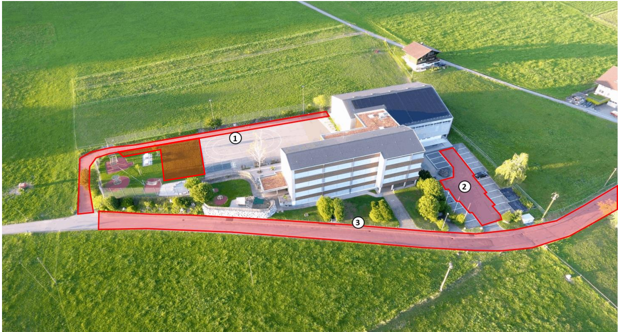
Luftaufnahme Schulhaus Ziegelacker; 20130902; R. Hunziker
